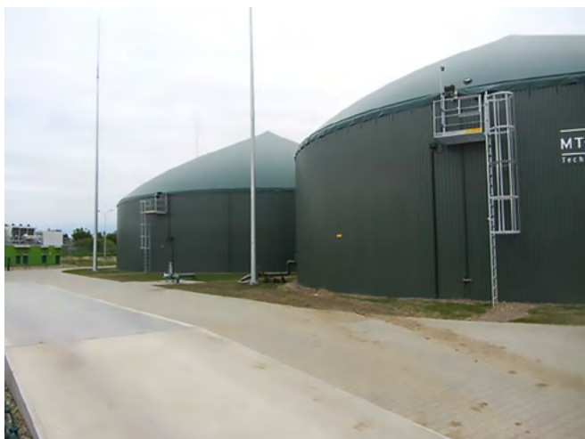
Rysunek 1. Zbiorniki fermentacyjne biogazowni (fot. T. Gardziola)
